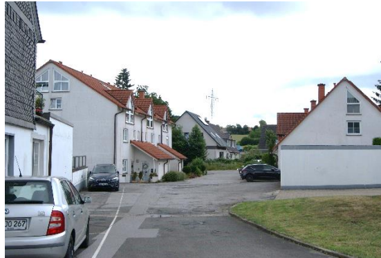
Abb. 28: Seitenstraße der Elberfelder Straße (Quelle: planinvent 2020)
